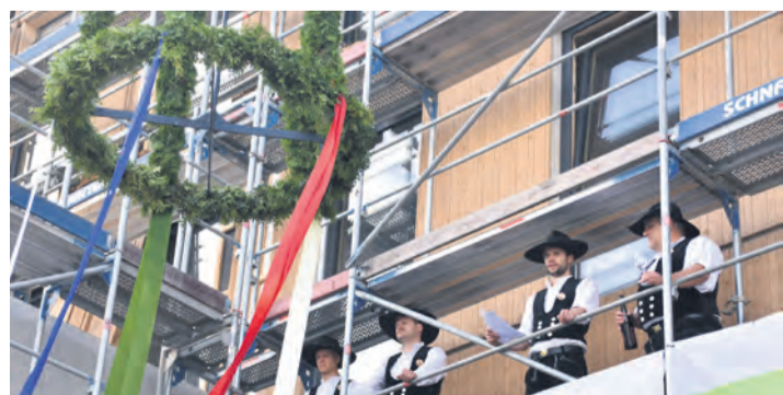
Andres Haller (Zweiter von rechts) von der Zimmerei Markus Haller durfte den traditionellen Richtspruch für den Neubau der Stadtwerke Radolfzell verlesen. sub-Bild: Philipp Findling
