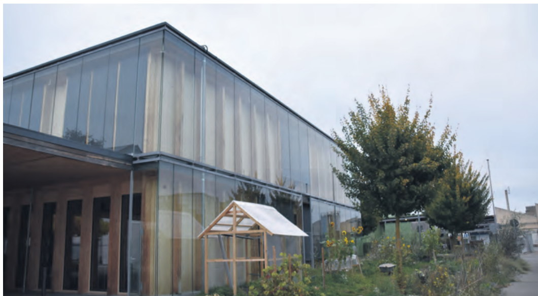
Nicht nur für die Ratoldusschule, sondern für alle Radolfzeller Schulen möchte die Zeller Stadtverwaltung im Laufe des nächsten Jahres im Rahmen eines Hitzeschutzkonzepts Schutzmaßnahmen auf den Weg bringen.
