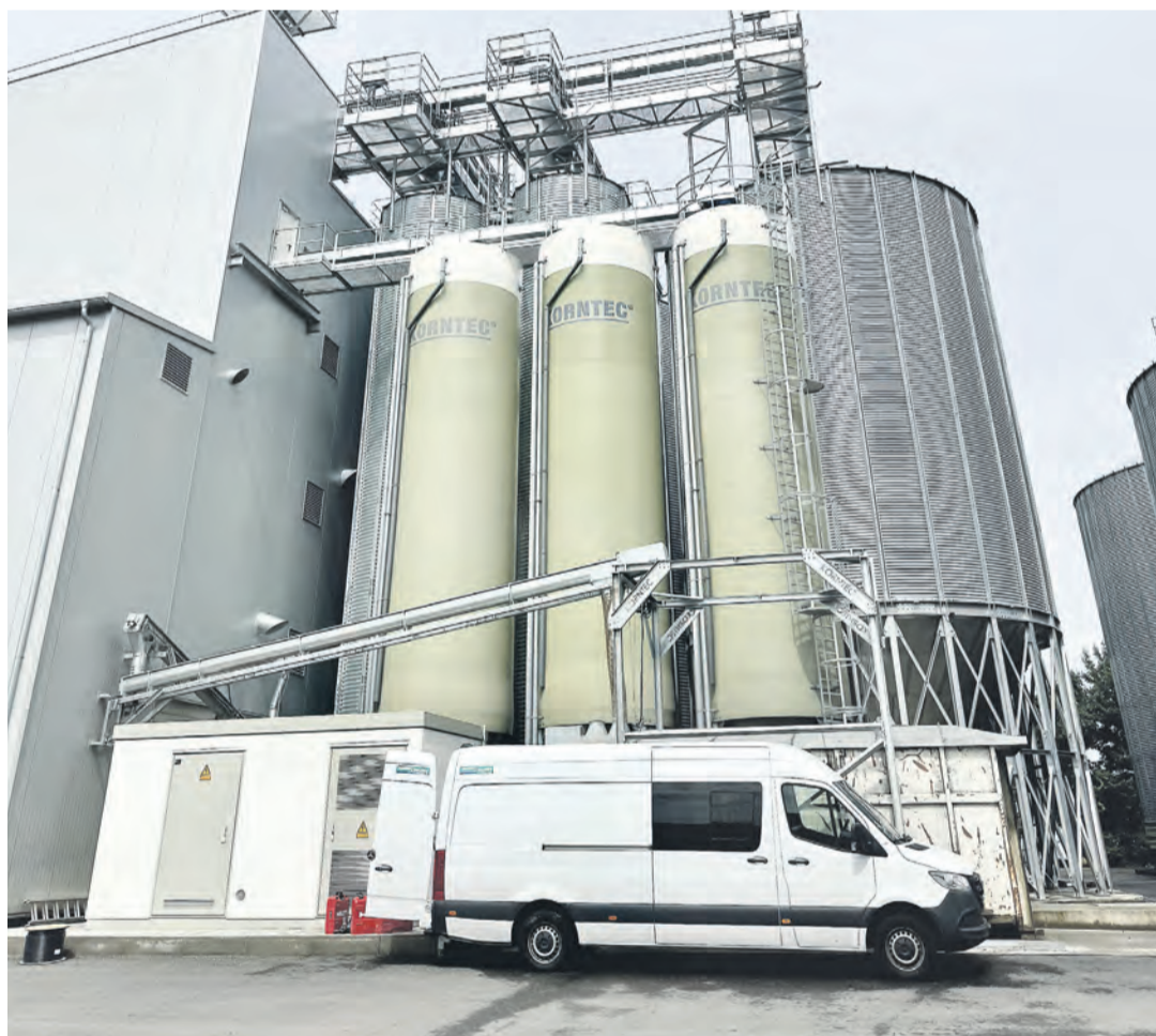
Silos mit rund 6.000 Tonnen Lagerkapazität für Bio-Getreide sind ein klares Signal dafür, wie viel Bedeutung die ZG Raiffeisen der Bio-Landwirtschaft beimisst.
