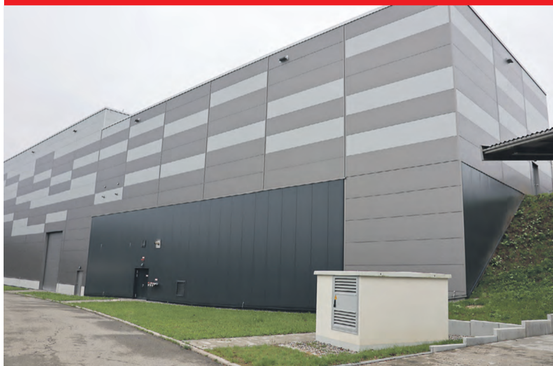
Ein Teil des neuen Shuttle-Lagers wurde durch umfangreiche Bauschutzmaßnahmen ergänzt.
