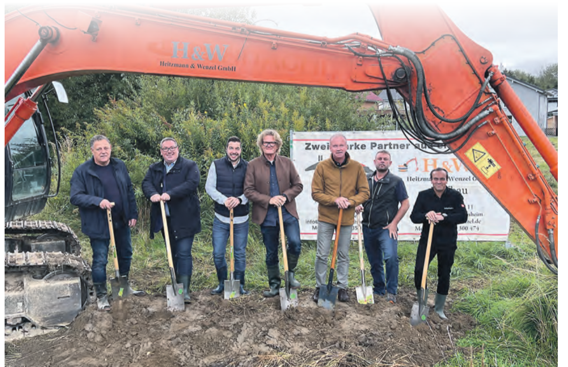
Der Spatenstich erfolgte im Oktober 2024. Nach nur elf Monaten Bauzeit konnte der Neubau erfolgreich eröffnet werden. swb-Bild: extrutec
