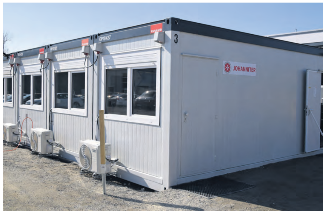
Die neue Rettungswache der Johanniter in der Zeppelinstraße. Über die nächsten 18 Monaten wird der Standort geprüft. Danach wird über einen Neubau entschieden. swb-Bild: Tobias Lange
