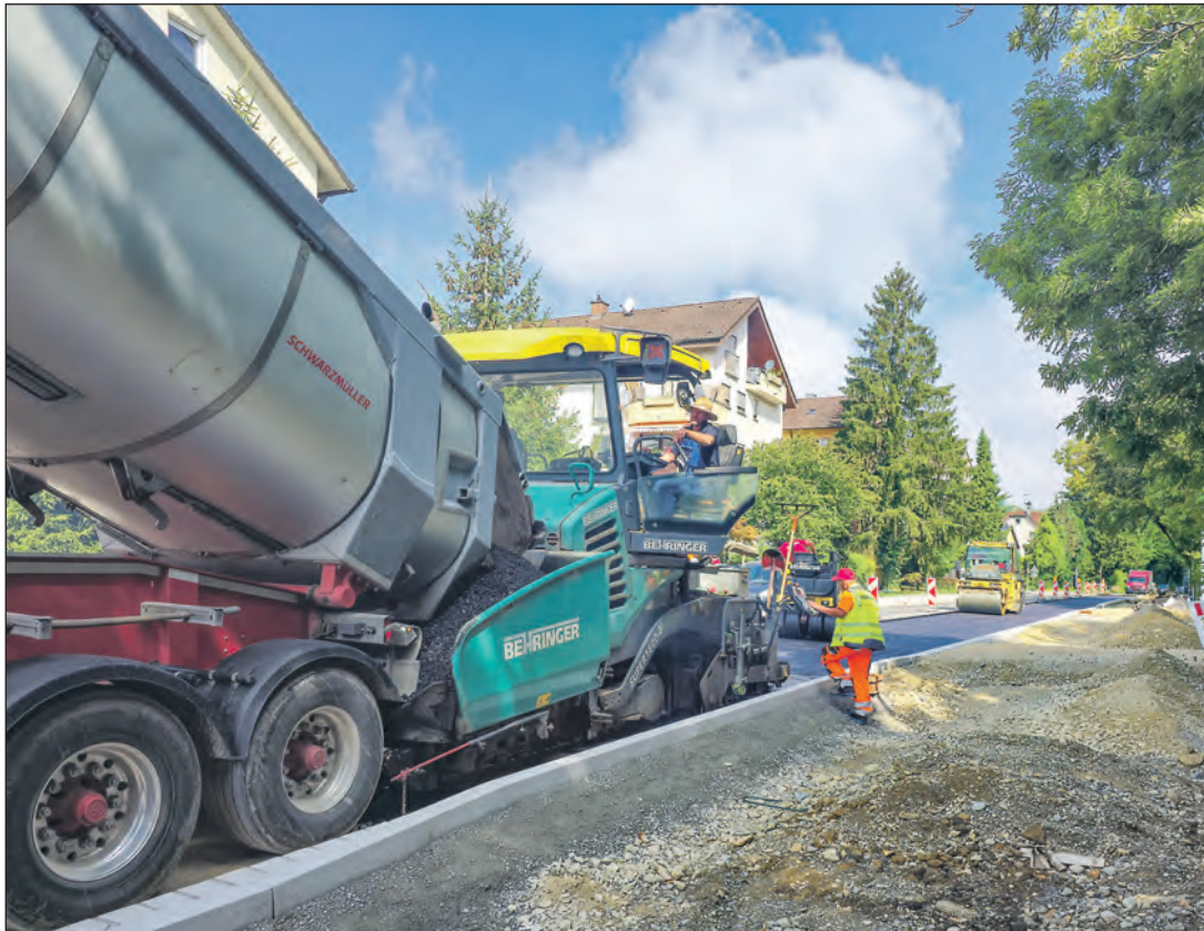
Die Bauarbeiten an der Hohenkrähenstraße verlaufen weiter planmäßig. Derzeit wird der Fahrbahnabschnitt zwischen der ZG-Tankstelle und dem Rebsteig auf einer Länge von 300 Metern asphaltiert.
