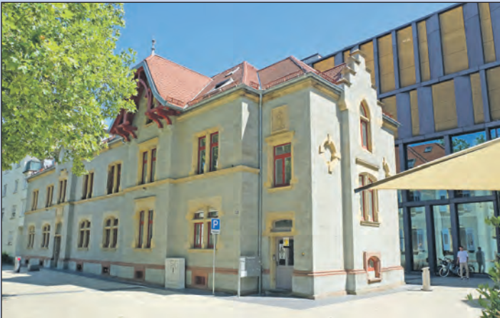
Das Alte Zollhaus in der östlichen Innenstadt konnte dank der Städtebauförderung erfolgreich saniert werden.
