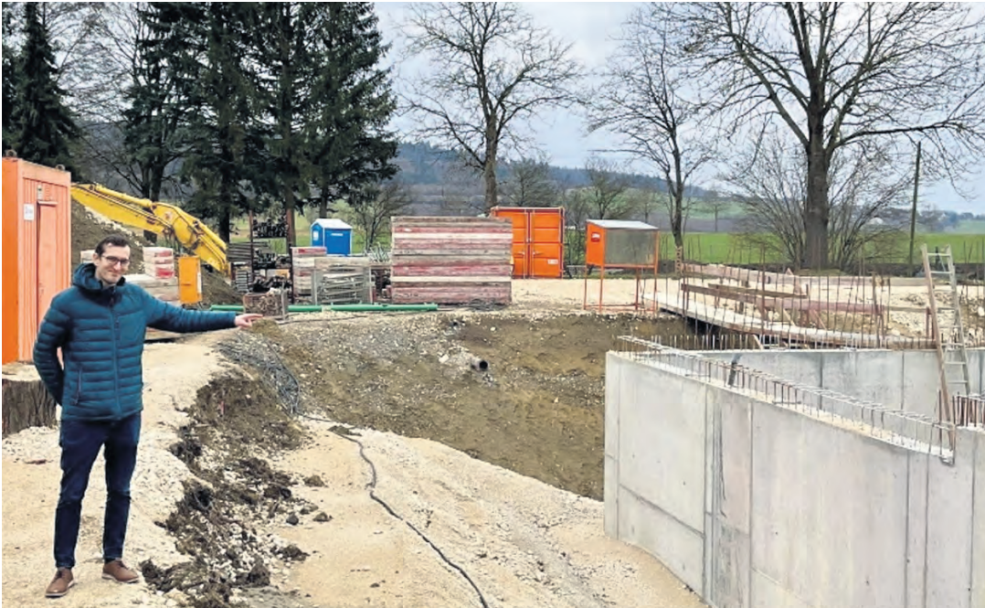
Lars Unden, Projektingenieur Wärmenetze beim Singener Bürgerunternehmen Solarcomplex AG, erläuterte vor Ort auf dem Gelände der ehemaligen Kläranlage die Erweiterung des Wärmenetzes Hilzingen von derzeit 5,2 Kilometer Länge auf dann etwa 13,5 Kilometer. swb-Bild: Bernhard Grunewald
