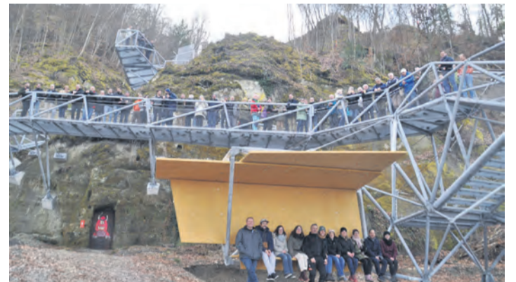
Erster Belastungstest: Die rund 70 Personen, die bei der Exkursion in die Marienschlucht dabei waren, hat die Stahlkonstruktion schonmal ausgehalten. swb-Bild: Anja Kurz
