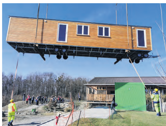
Mit einem mobilen Kranwagen wurde der neue Bauwagen für den Unterseekindergarten platziert.
