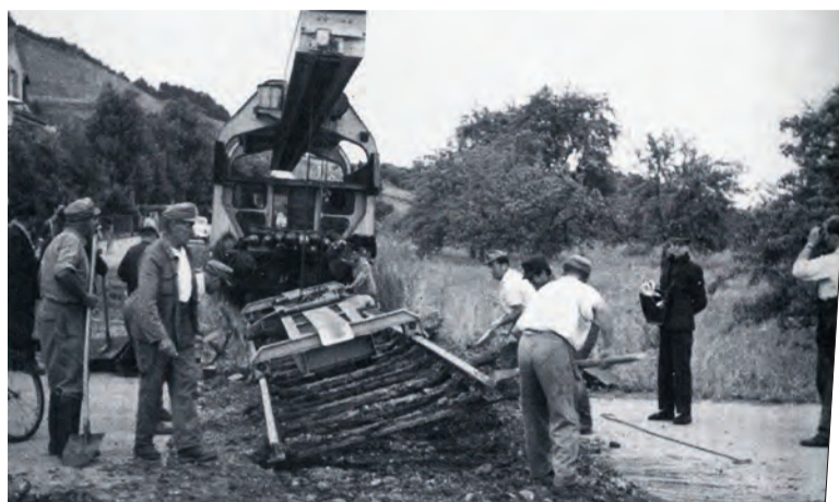
Mithilfe von schwerem Gerät wurden die Gleise der Randenbahn 1967 wieder herausgerissen. swb-Bild: Werner Gönner
