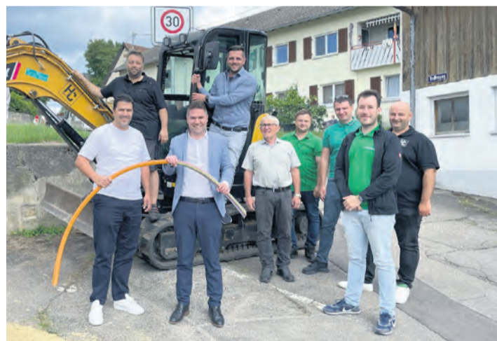
Zum Spatenstich für den Glasfaserausbau in Binningen kamen zahlreiche Vertreter von Gemeinde- und Ortsverwaltung sowie der beteiligten Unternehmen zusammen. swb-Bild: Stiegeler
