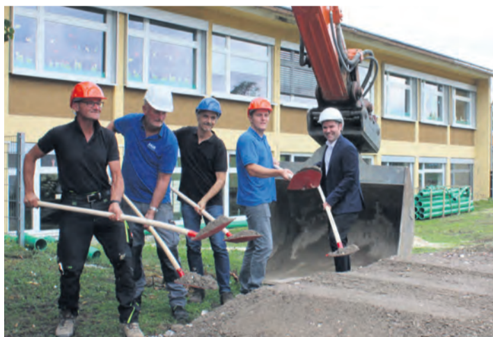
Ingo Heine (R.Britsch, von links), Matthias Baur (Baur Bauunternehmung), Andreas Ernst (Eco Architektur), Domenik Mayer (Bauamt) und Bürgermeister Holger Mayer beim Spatenstich für die Grundschulerweiterung.
