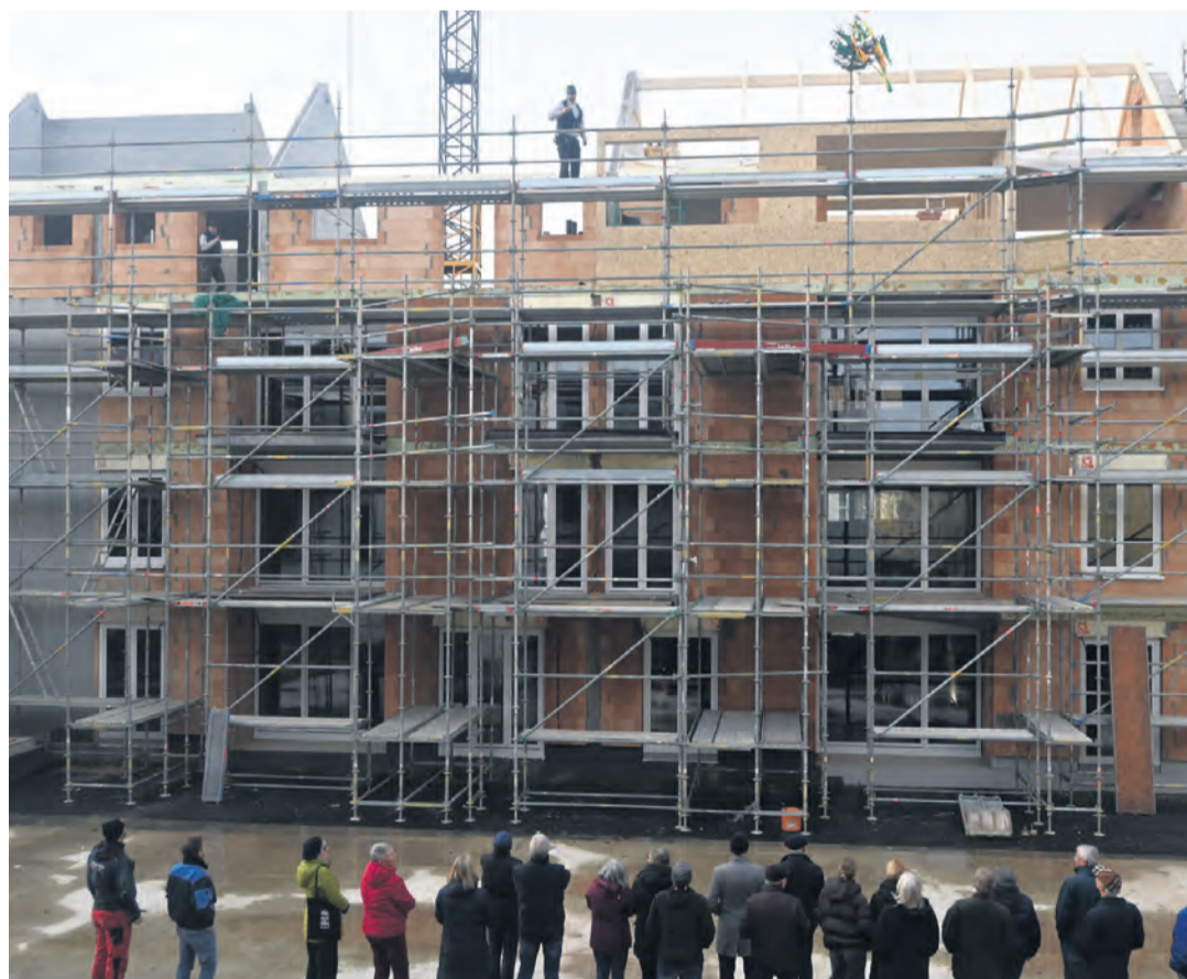
Ein neues Gebäude nimmt Form an in der Fliederstraße in Gottmadingen. Zum traditionellen Richtspruch für den Neubau mit 22 Wohneinheiten blickten die Gäste gespannt in die Höhe.
