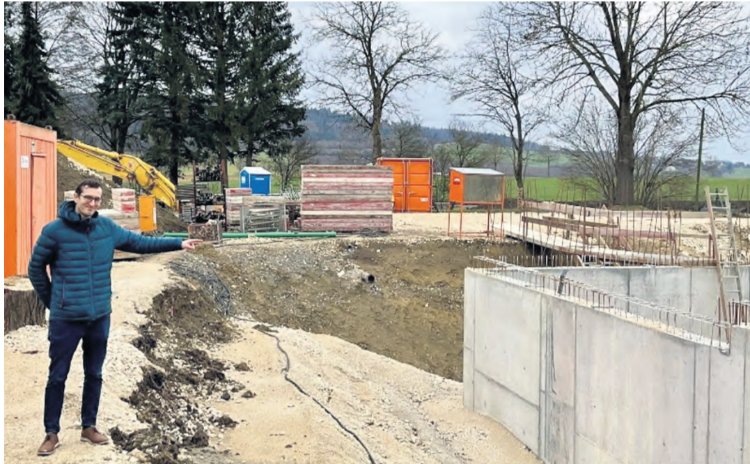
Lars Uden, Projektingenieur Wärmenetze beim Singener Bürgerunternehmen Solarcomplex AG, erläuterte vor Ort auf dem Gelände der ehemaligen Kläranlage die Erweiterung des Wärmenetzes Hilzingen von derzeit 5,2 Kilometer Länge auf dann etwa 13,5 Kilometer. swb-Bild: Bernhard Grunewald
