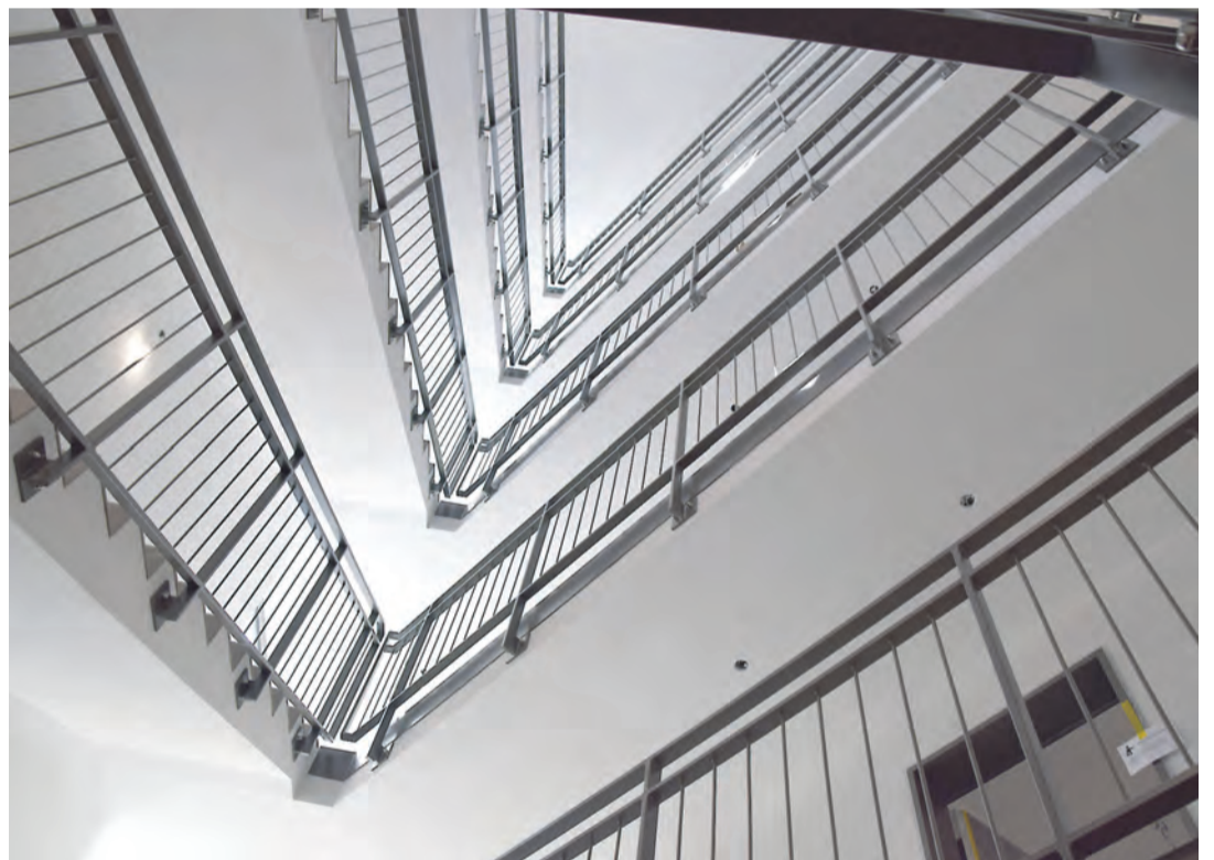
Die Etagen sind über eine Treppe sowie zwei Aufzüge miteinander verbunden und erreichbar.
