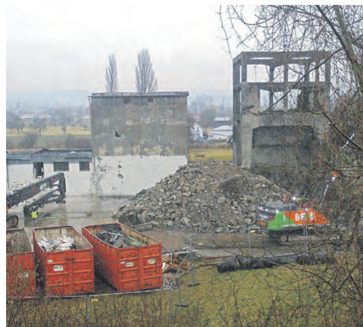
Zur Zeit wird das ehemalige historische Basaltwerkgebäude in Mühlhausen abgetragen und eingeebnet. swb-Bild: Helmut Fluck
