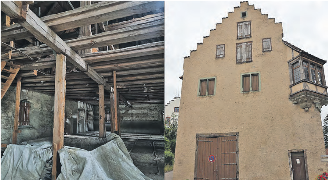
Seit 1570 steht das Kornhaus. Jetzt soll es vom Dachstuhl bis in den Keller saniert werden. Links ist das Obergeschoss zu sehen und rechts die Außenfassade des Kornhauses. swb-Bilder: Pia Schaible
