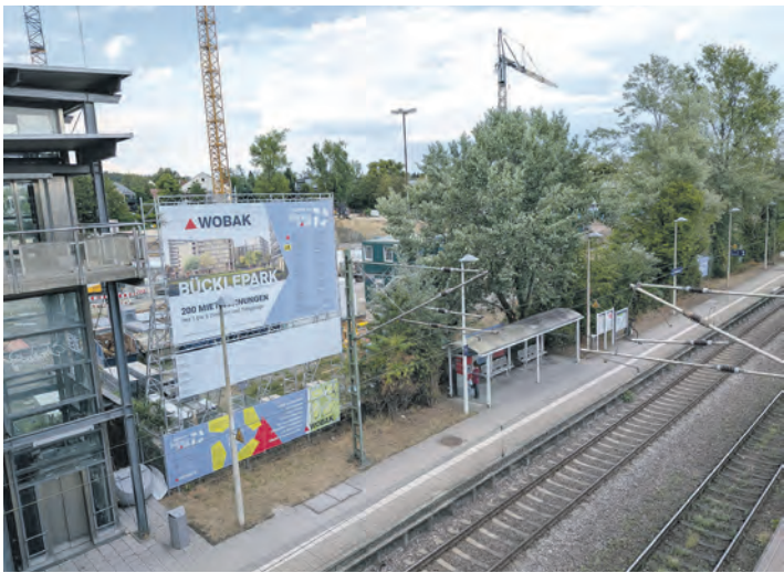
Am Bücklepark in Konstanz finden Kanalarbeiten statt, die auch den Schienenverkehr beeinflussen. Dafür wird ein Schienenersatzverkehr eingerichtet.
