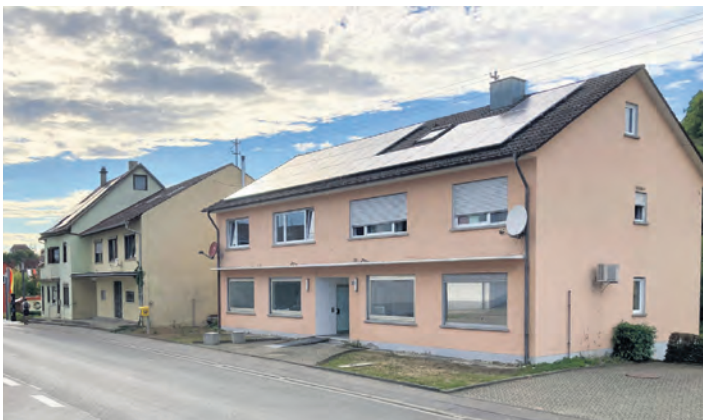
Die alte Sparkassenfiliale in der Hauptstraße 27 in Aach ( im Bild rechts) soll zu einer Hausarztpraxis umgebaut werden, die die Gemeinde benötigt.
