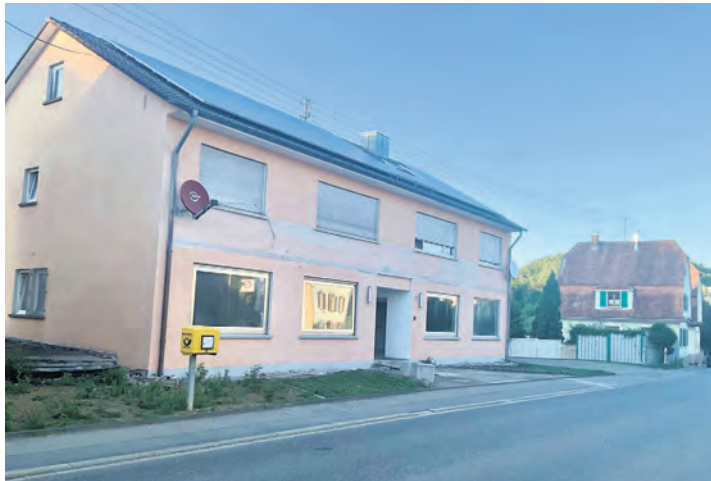
Grünes Licht für den Umbau der alten Sparkassenfiliale zu einer Hausarztpraxis gab der Gemeinderat der Stadt Aach.
