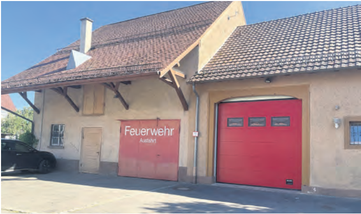
Das alte Feuerwehrhaus gehört seit Jahrzehnten zum prägenden Ortskern Randeggs und soll nun behutsam umgebaut werden. sub-Bild: Bernhard Grunewald
