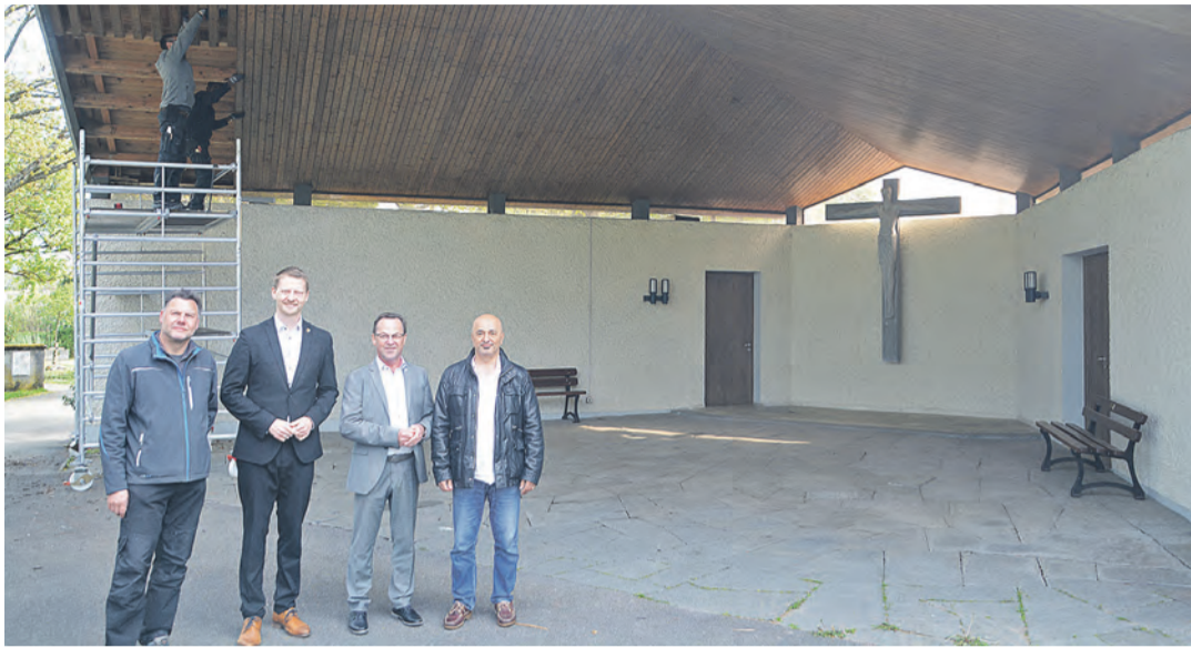
Alexander Baur, Leiter Abteilung Friedhofswesen (von links), Oberbürgermeister Simon Gröger, Böhringens Ortsvorsteher Jürgen Keck und Projektleiter Engin Ersoy an der Aussegnungshalle, deren Umbau bereits begonnen hat.
