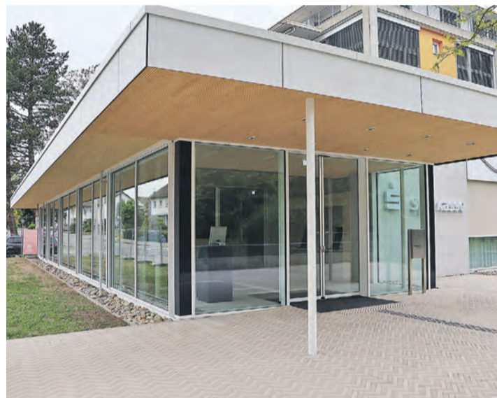
Die neue Sparkassen-Filiale in der Hohenhewenstraße öffnet am 6. Mai ihre Türen. Bei der Gestaltung wurde auf helle Farben und Naturmaterialien geachtet. swb-Bild: Juleda Kadrija
