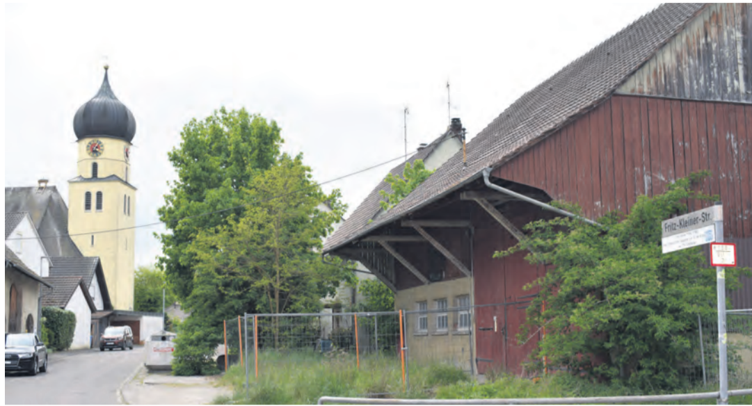
Hier bei dem Aerial in der Fritz-Kleinerstrasse (rechts) entsteht die »Neue Mitte« vom Radolfzeller Ortsteil Böhringen, sowie das neue Dorfgemeinschaftshaus. Die Bauarbeiten beginnen im Herbst diesen Jahres.
