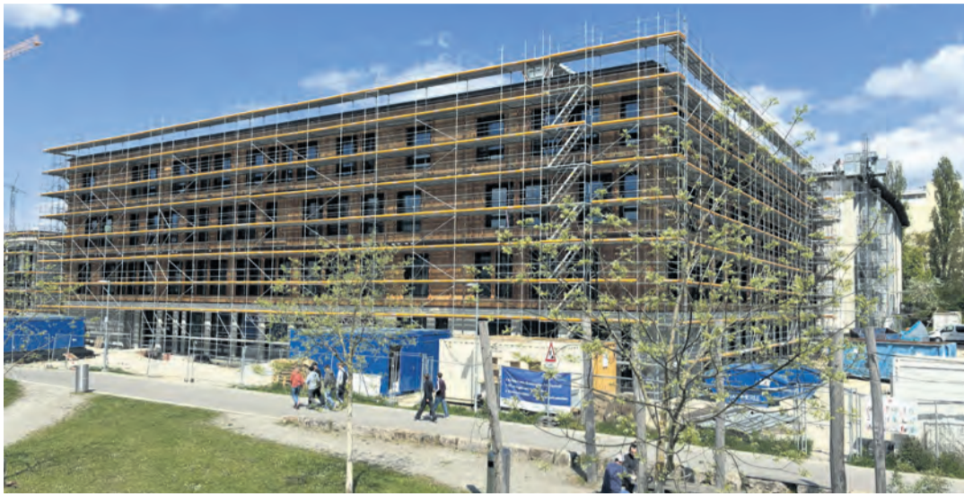
Der Bau des Berufsschulzentrums Konstanz macht stetig Fortschritte. So soll unter anderem die Bauphase Süd dem Planungsbüro Drees & Sommer zufolge im Sommer 2027 abgeschlossen werden. swb-Bild: Landratsamt Konstanz
