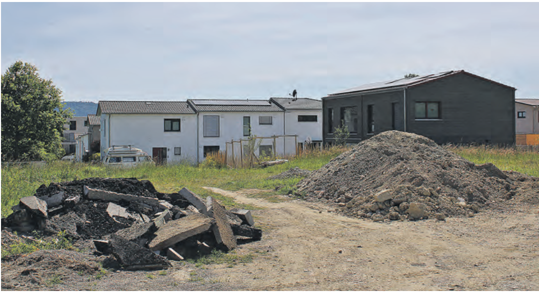
Anwohner des Radolfzeller Neubaugebiets beklagen den Zustand der Straßen und warnen vor Schäden und Verschmutzung durch Starkregen.
