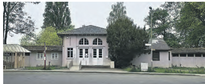
Das Strandbad auf der Mettnau ist von den bisherigen Pächtern an die Stadt übergeben worden.
