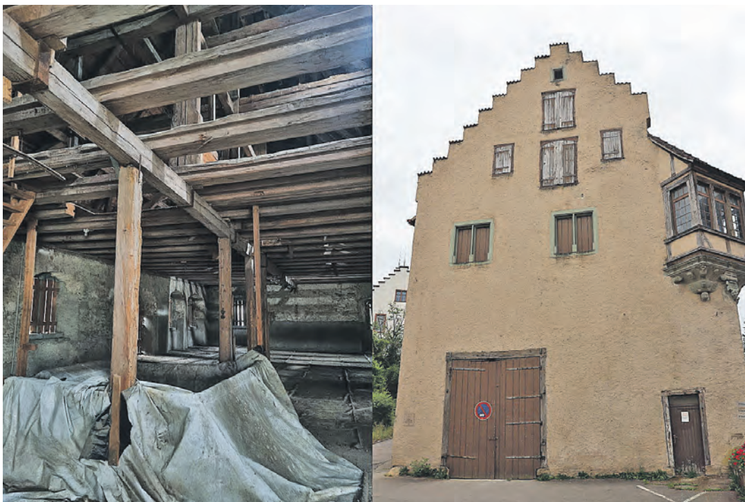
Seit 1570 steht das Kornhaus. Jetzt soll es vom Dachstuhl bis in den Keller saniert werden. Links ist das Obergeschoss zu sehen und rechts die Außenfassade des Kornhauses. swb-Bilder: Pia Schaible
