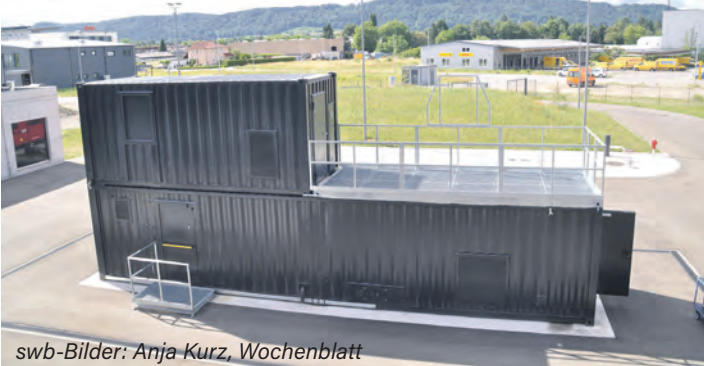
Der Brandsimulationscontainer besteht aus drei Räumen mit vier Brandstellen, sowie verschiedenen Technikräumen.
