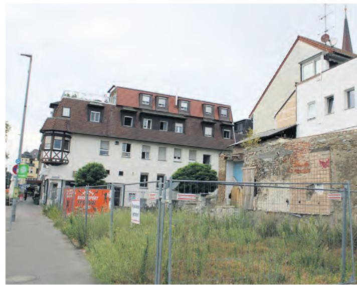
Die Brandruine am Rande der Radolfzeller Altstadt direkt gegenüber des Busbahnhofes steht im Radolfzeller Gemeinderat wieder zur Diskussion. swb-Bild: Eron Metolli
