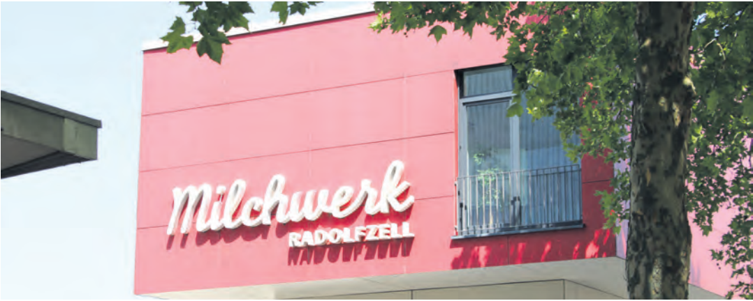
Das Milchwerk in Radolfzell erhält aufgrund mehrerer Risse in Foyerboden zusätzliche Mittel zur Behebung der Schäden. Somit übersteigt der Veranstaltungsort sein Budget für das Jahr 2026 um rund 50.000 Euro.
