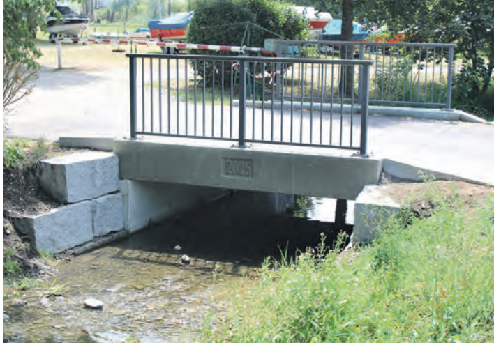
Die Brücke »Kleine Espen« nahe des Bahnhofs in Markelfingen kostet der Stadt Radolfzell trotz ihrer überschaubaren Größe fast 500.000 Euro. Eine einfache Sanierung war laut Ingenieurbüro nicht wirtschaftlich, daher erfolgte ein Ersatzneubau, der nun zusätzlich 45.000 Euro kostet. sub-Bild: Eron Metolli
