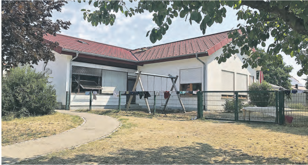
Der Kindergarten St. Raphael muss neugebaut werden.
