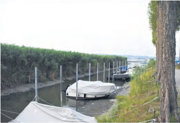
Die Molensicherung am »Alten Hafen« in Moos wird nun aufgrund der bevorzugten Stahlvariante kostengünstiger. sub-Bild: Philipp Findling
