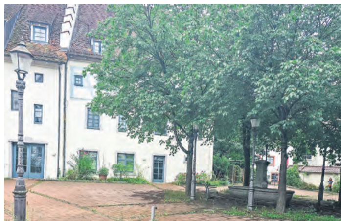
Der Innenhof, der die Gebäude der Poststr. 15 und der Seestraße 46 verbindet, in denen sich das ehemalige Pflegeheim befand. sub-Bild: Stadt Radolfzell
