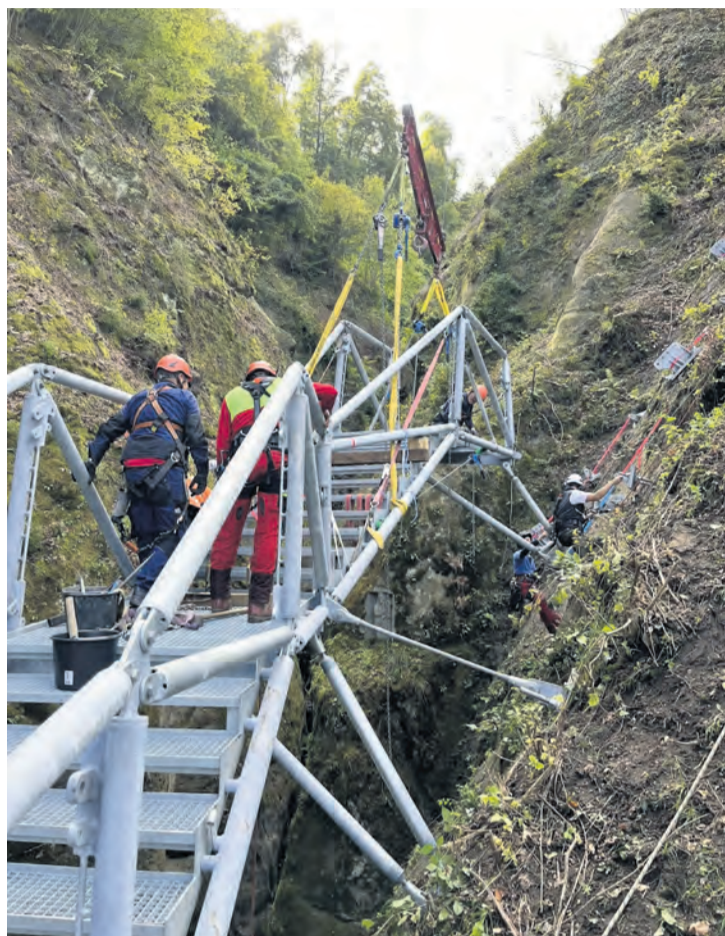
Der neue Weg über der Marienschlucht ist kein alltägliches Projekt. Die Mitarbeiter der Firma Rettich Stahlbau mussten die Stahlkonstruktion in 52 Höhenmetern an Felsen montieren.
