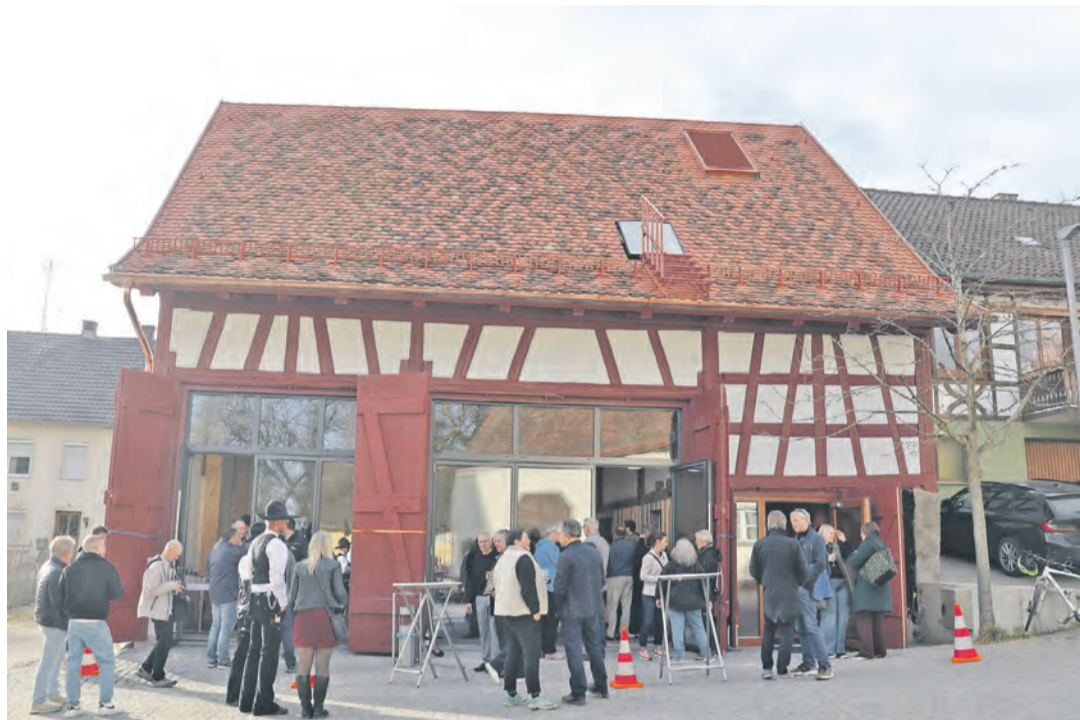
Die Gemeindegemeinschaftshaus Güttingen erstrahlt nun im neuen Glanz und soll nun als Treffpunkt für Vereine sowie ein Ort des Miteinanders und der Begegnung geschaffen werden.
