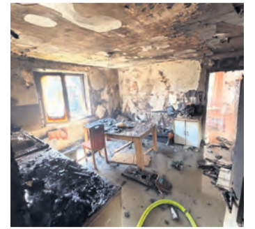
Bei einem Wohnungsbrand in der Nelkenstraße entstand ein Sachschaden von rund 100.000 Euro. swb-Bild: Feuerwehr
