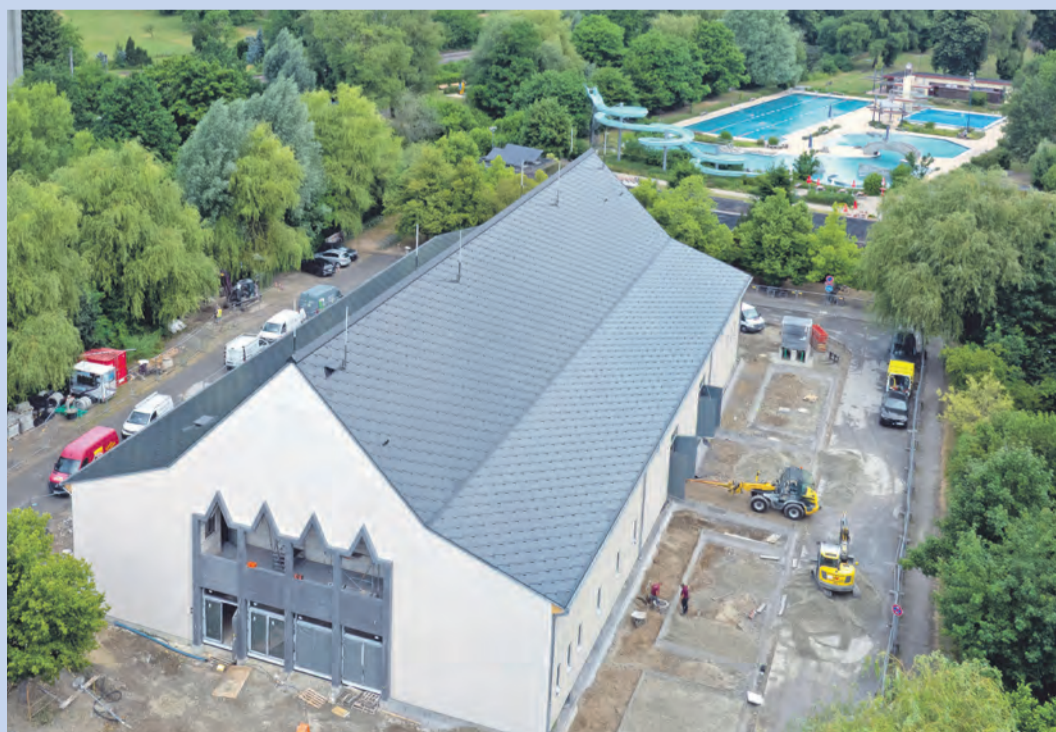
Durch die energetische Kopplung mit der PV-Anlage auf dem Dach der neuen Scheffelhalle (im Vordergrund) kann das Aachbad (gleich dahinter) ab dieser Saison zu rund 90 Prozent mit lokal erzeugter, erneuerbarer Energie versorgt werden.
