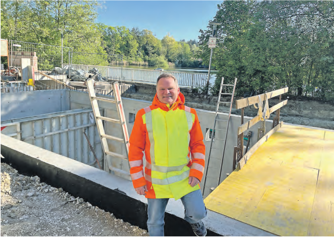
Der neue Lamellenklärer und das Überlaufbecken am Kanalufluss am Ziegeleiweiher sind fast fertiggestellt. Joachim Dutt betreut das Projekt von Seiten der Stadtwerke Singen.
