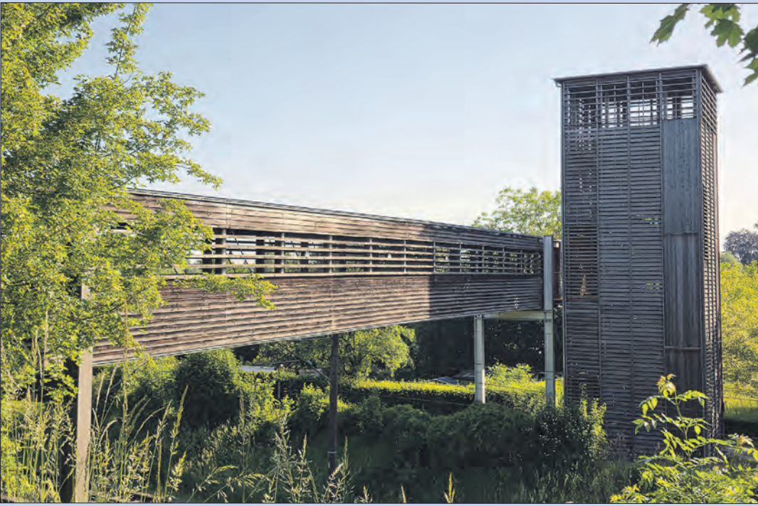
Die Schäden an der Blechdachkonstruktion sind einfach zu groß: Der Rückbau des Brückenteils der Turmbrücke auf dem (ehemaligen) Laga-Gelände findet im Juli statt – während der mehrtägigen Sperrung der Bahnstrecke. Der Rückbau mit anschließender Entsorgung ist die wirtschaftlichste Lösung. Der Turm selbst bleibt bestehen und weiterhin gesperrt.
