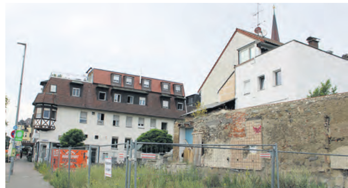
Die Brandruine am Rande der Radolfzeller Altstadt direkt gegenüber des Busbahnhofs steht im Radolfzeller Gemeinderat wieder zur Diskussion. sub-Bild: Eron Metolli
