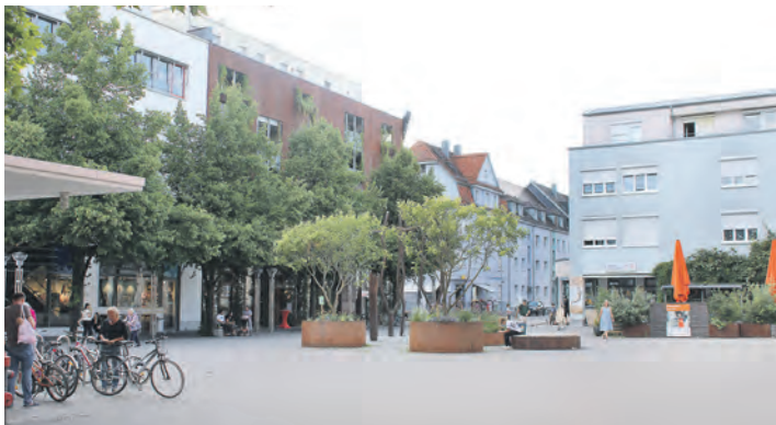
Der Heinrich-Weber-Platz ist einer der insgesamt vier Orte in Singen, an dem mobile Nebellanlagen aufgestellt werden sollen. Diese sorgen durch Wassernebel bei Hitzeperioden für eine kurze Abkühlung.
