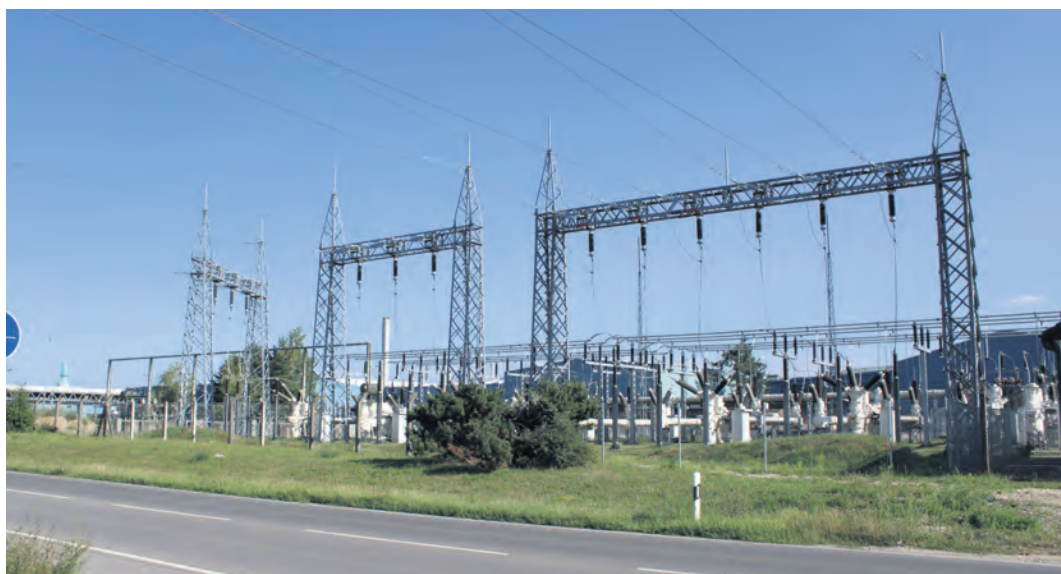
Auf dem Gelände des ehemaligen Umspannwerks der Naturenergie in Singen ist ein 25-Megawattstunden-Batteriespeicher geplant. Die Anlage soll künftig dazu beitragen, das Stromnetz zu stabilisieren und überschüssige Energie aus erneuerbaren Quellen zwischenspeichern.
