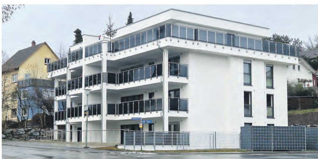
Zu den Aufgaben des Unternehmens gehören unter anderem die Altbauanierung sowie der Außenputz, der auf diesem Foto fertiggestellt wurde. swb-Bild: Stuckateur Berisha
