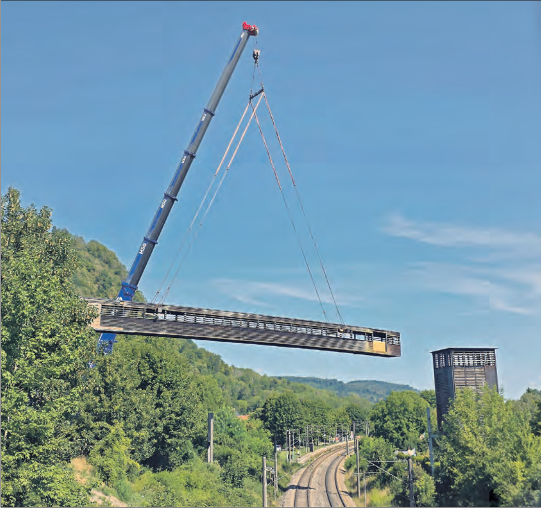
Die 31 Tonnen schwere und 43 Meter lange Laga-Turmbrücke wurde rückgebaut. Der Laga-Turm selbst bleibt (vorerst) bestehen. Die Turmbrücke wird entsorgt.
