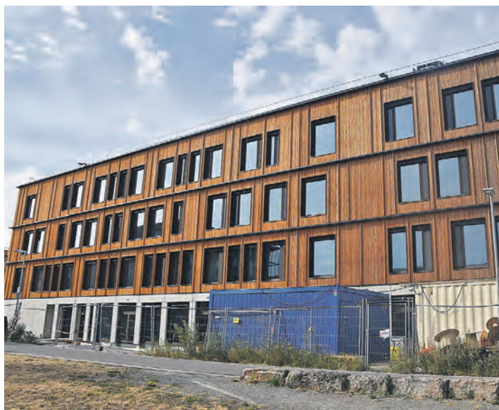
Die Bauzäune sind weg: Der Neubau des BSZ Konstanz kann nun voll zur Geltung kommen. swb-Bild: Philipp Findling
