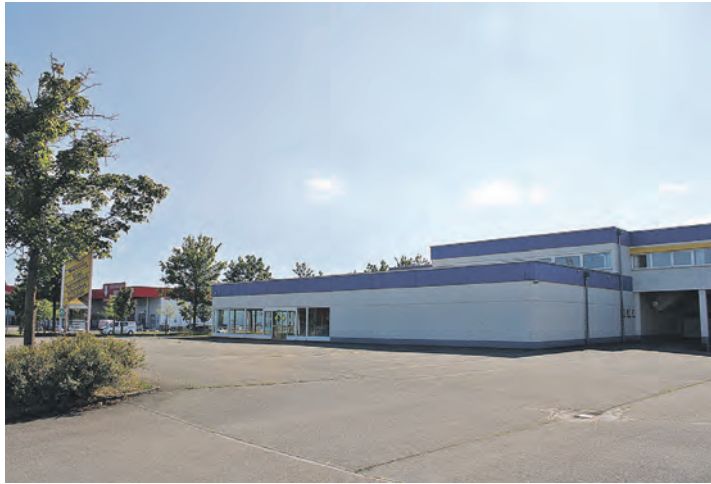
In der ehemalige Industriehalle der Eisen-Auer GmbH in Singen wird nach über zwei Jahren Leerstand ein Fitnesscenter entstehen.
