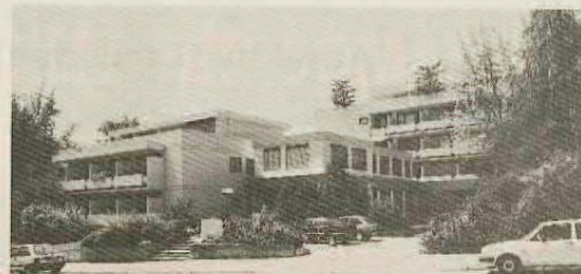
Wichtige Entscheidungen waren in der evangelischen Kirchengemeinde in den sechziger Jahren zu treffen, doch nur eines der damals diskutierten Vorhaben wurde zu jener Zeit fertig. Am 22. Februar 1969 konnte das evangelische Altersheim in der Anton Bruckner-Straße (im Bild) seiner Bestimmung übergeben werden. Der Bau, den Pfarrer Theo Odenwald initiiert hatte, wurde im Dezember 1966 begonnen. swb-Bild: of
