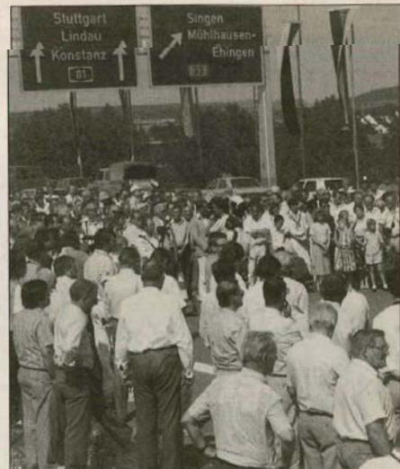
Eröffnung der Autobahn A 98 im Jahr 1988: Nicht nur die Grundlage für das Stockacher Industriegebiet Hardt wurde hier geschaffen.
