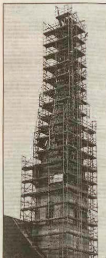
Gerüste für das zeitgemäße »Outfit«: Der Kirchturm von Peter-und-Paul in Singen war ein solches Beispiel für starke Handwerkskunst.
