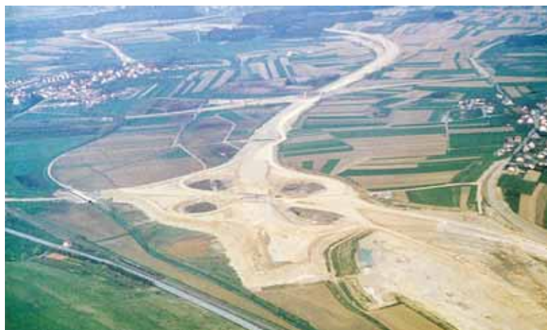
Das Autobahnkreuz Singen Ende der 70er Jahre im Bau. Endlich war die Autobahn in der Region angekommen. Bis sie nach Konstanz vorgedrungen ist, werden noch einige Jahre ins Land ziehen. swb-Bild: Stadtarchiv Singen
