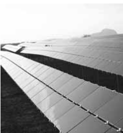
Der Solarpark Rickelshausen auf der ehemaligen Kreismülldeponie ist das bisher größte Projekt von »solarcomplex« mit einer Leistung von 1,65 Megawatt.
