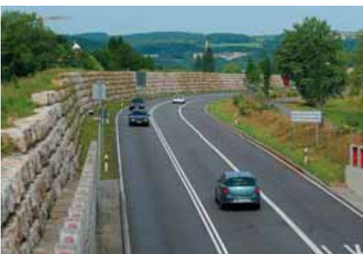
Der Bietinger Tunnel, um den viele Jahre lang gekämpft werden musste, mündet nach 253 Metern in einem riesigen Lärmschutzbau bis zur bereits 1990 eingeweihten Gemeinschaftszollanlage Bietingen/Thayngen. swb-Bild: of
