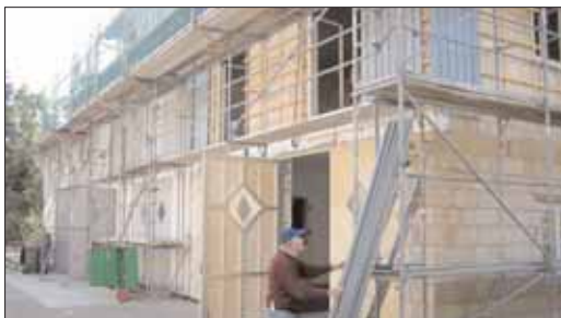
Ein Stück mehr für die Zukunft: Der Rohbau steht.
